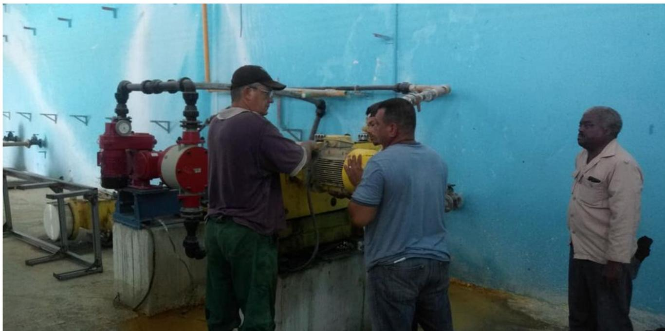
Los operarios de Mantenimiento del Acueducto trabajan en el cambio de la bomba dosificadora de sulfato de alúmina en la Planta Potabilizadora de la Ciudad de Camagüey.
